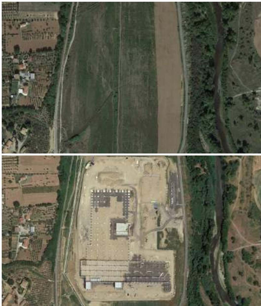
Figura 160. Consumo di suolo di circa 15 ettari (111 edifici, 122 cantieri) per la realizzazione di un nuovo supermercato nel comune di Montalto Uffugo (Cosenza), realizzato in area a elevata pericolosità idraulica. In alto l'immagine è relativa al 2019, in basso al 2022
