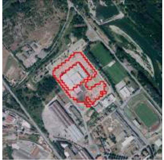
Figura 249. L'area individuata come consumo di suolo tra il 2021 e il 2022 per 2,55 ettari è la realizzazione di un piazzale per l'area produttiva di Sant'Andrea nel Comune di San Giovanni Valdarno, presentato come impianto d'eccellenza (ABB S.p.A.) specializzato nella realizzazione dei sistemi di ricarica per la mobilità sostenibile (Fonte: ortofoto 31/07/2021 Regione Toscana)
