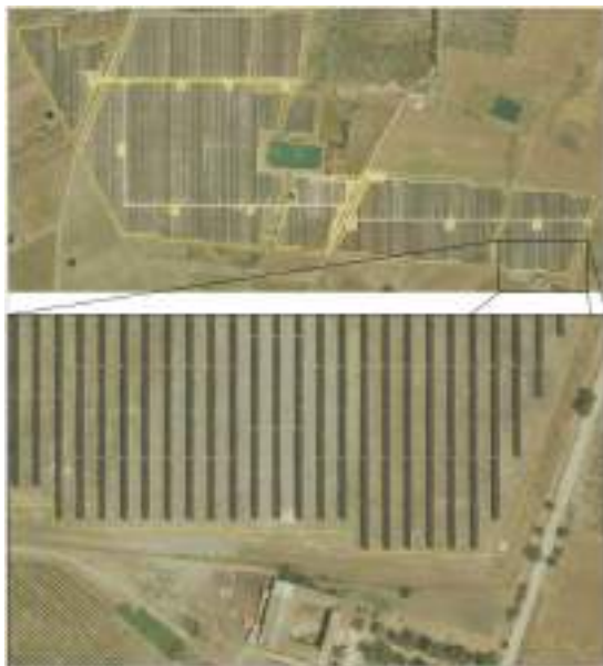
Figura 128. Esempio di impianto fotovoltaico a bassa densità (circa 110 ettari; codice 205), comune di Mazara del Vallo (Trapani). Le informazioni fornite dalla ditta installatrice riportano un'altezza dei moduli inseguitori da terra, in posizione orizzontale degli stessi, di circa 2,6 metri e una distanza tra le file (considerando il piede delle strutture di supporto) di circa 12 metri. Questa distanza si riduce a circa 9,6 metri considerando l'ingombro dei moduli completamente inclinati e a 7,4 metri con i moduli orizzontali
