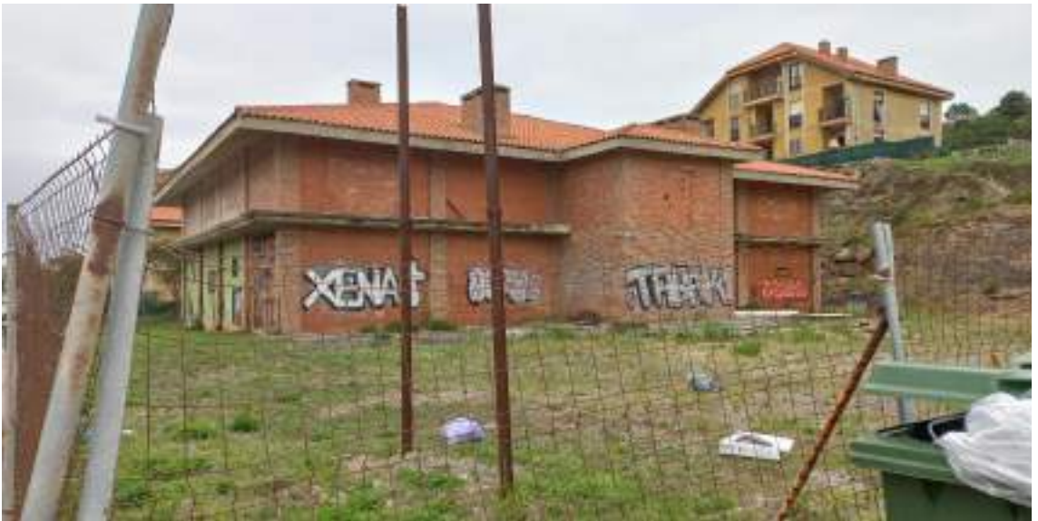
Figura 10. Un edificio abbandonato
