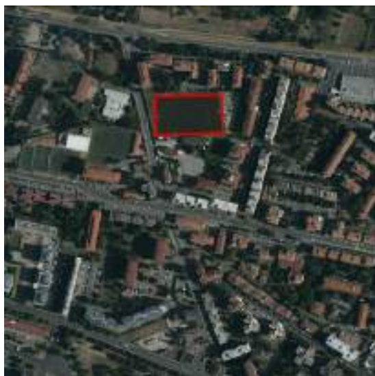
Figura 252. L'area individuata come consumo di suolo tra il 2021 e il 2022 per 0,66 ettari è dovuta alla riqualificazione (cambio di manto) di un campo sportivo già presente e situato nella periferia di Firenze (Fonte: ortofoto 14/08/2021 di Regione Toscana)
