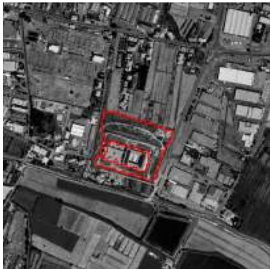
Figura 264. L'area individuata considerata come consumo di suolo tra il 2021 e il 2022 per 3,66 ettari è un esempio di rigenerazione di un'area produttiva preesistente (ortofoto 1996) in corso di rigenerazione nel Comune di Scandicci (insediamento marchio di eccellenza)
