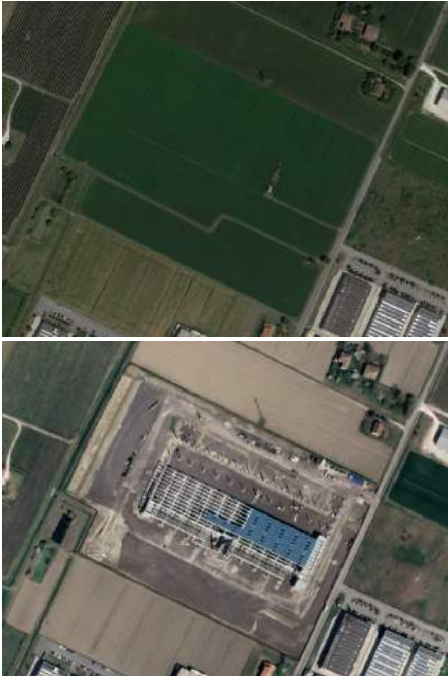
Figura 153. Consumo di suolo di 9,3 ettari, per la realizzazione di un nuovo polo logistico (111 edificio, 116 piazzale e 122 cantiere) nel comune di Sala Bolognese (Bologna) in area a elevata pericolosità idraulica. In alto l'immagine è relativa al 2021, in basso al 2022
