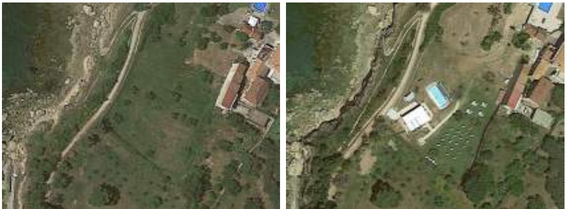
Figura 142. Consumo di suolo all'interno di un'area EUAP, nel comune di Castellabate (Salerno) nel Parco Nazionale del Cilento e Vallo di Diano, per la realizzazione di un nuovo edificio con annesso piazzale. Immagini a sinistra 2019 e a destra, 2022
