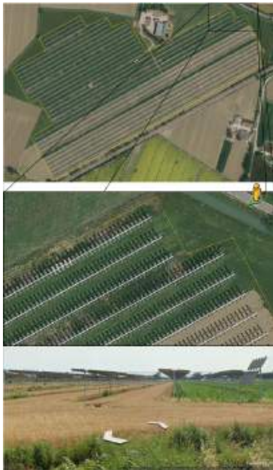
Figura 130. Impianto agrivoltaico elevato ad inseguimento su doppio asse. Comune di Monticelli d'Ongina (circa 17 ettari; Piacenza). In basso una vista da Google Street View da cui si nota l'altezza di installazione e la presenza di coltivazioni cerealicole
