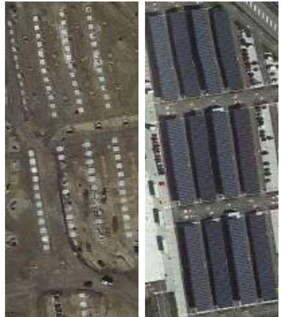
Figura 129. Esempio di pensiline fotovoltaiche a copertura di parcheggi auto (circa 1,3 ettari), comune di Torrazza Piemonte (Torino)
