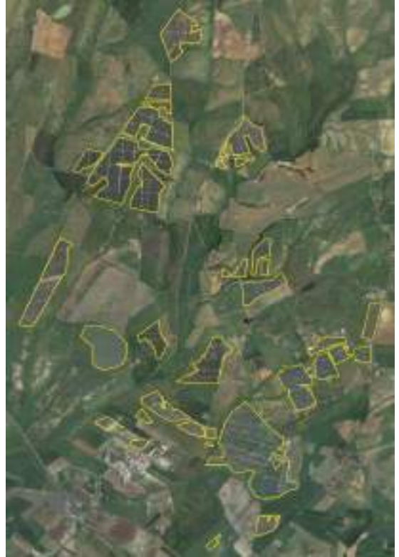
Figura 127. Esempio di impianti fotovoltaici installati su suolo utile (circa 405 ettari), comune di Montalto di Castro (Viterbo)
