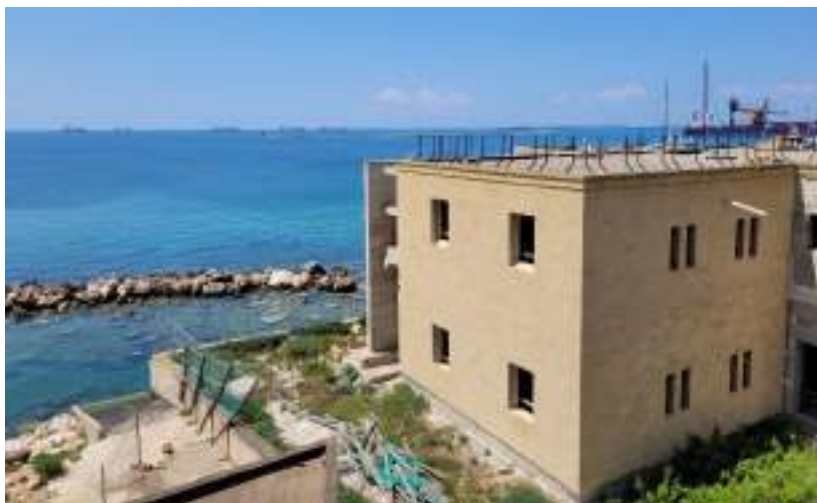
Figura 177. Un edificio abbandonato a ridosso della costa
