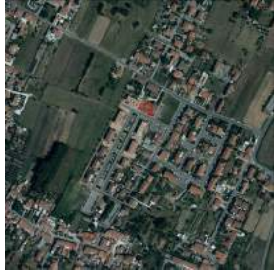
Figura 256. Esempio di intervento edilizio per il completamento di aree residenziali, l'esempio è la realizzazione di edifici a schiera nel Comune di Cascina (Fonte: ortofoto 14/08/2021 di Regione Toscana)
