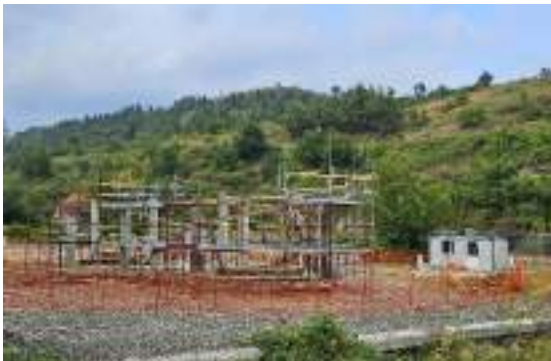
Figura 1. Un edificio in costruzione
