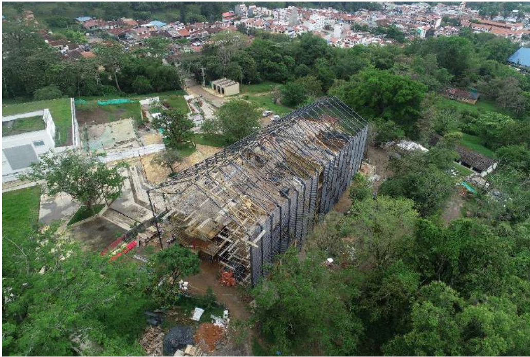
Fig. 3 | Edificio in costruzione. Vista dal drone (UIS, 2019).
