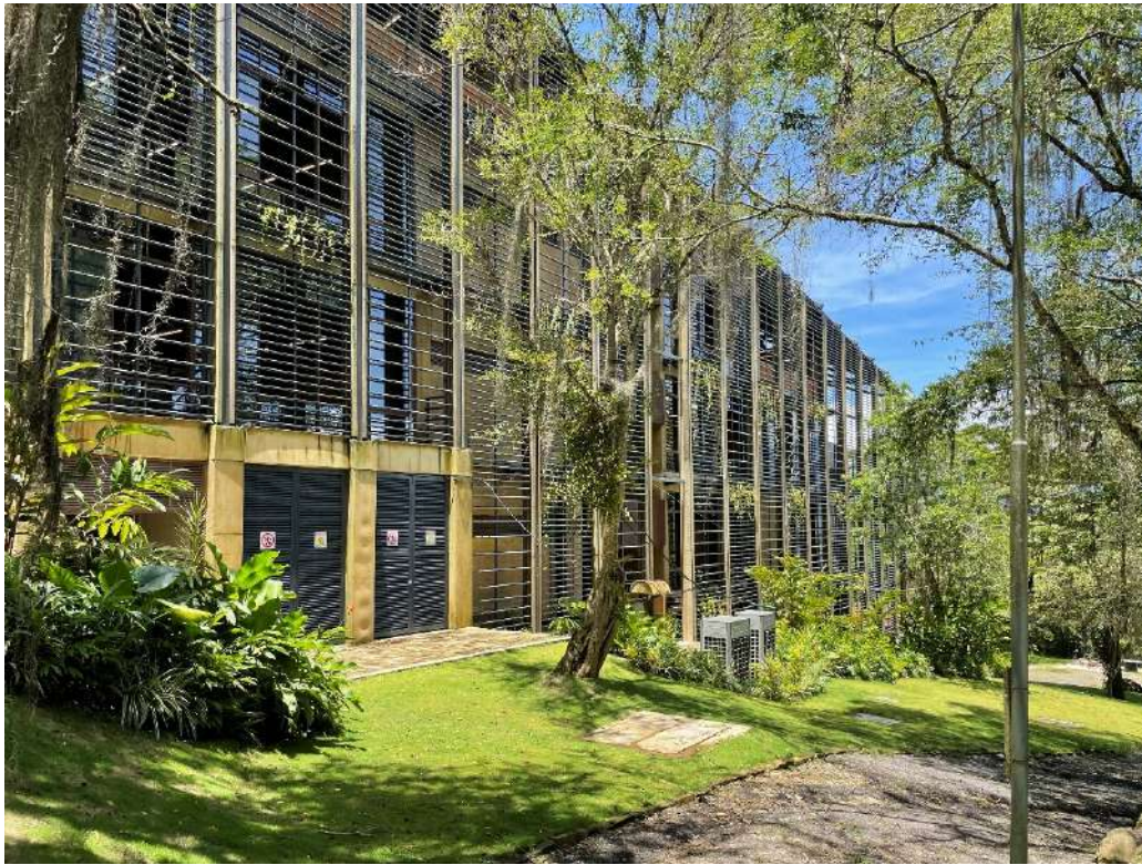
Fig. 9 | Fronte laterale permeabile e accessibile. (Luca Marzi, 2022).
