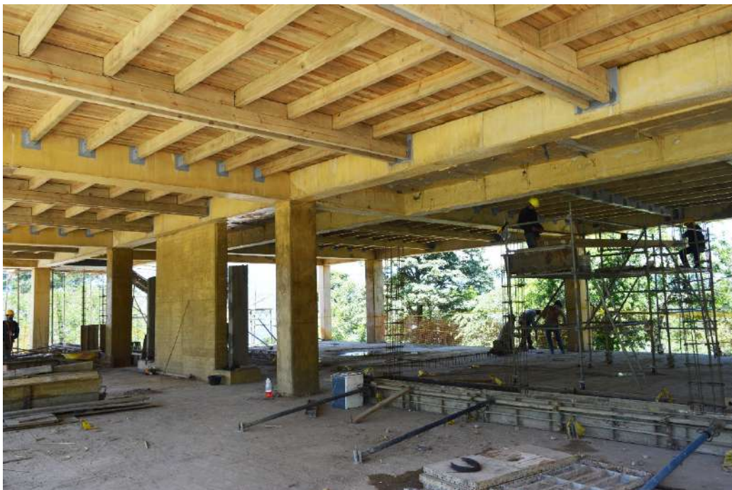
Fig. 5 | Intradosso dei solai in legno di pinus patula (UIS, 2019).
