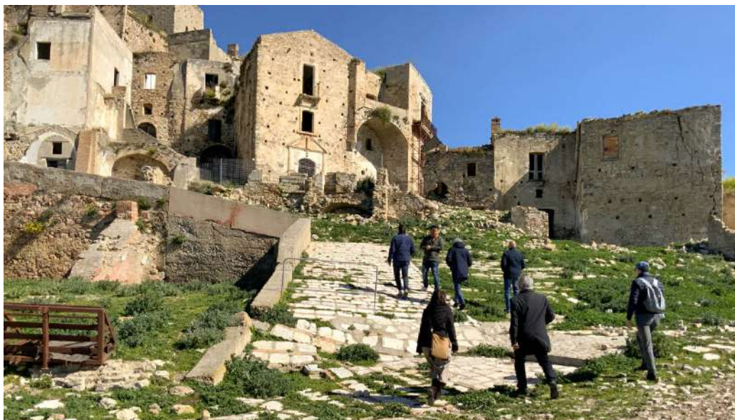
Fig. 1 | Sopralluogo esplorativo tra i ruderi di Craco Vecchia (MT). Foto Rossella Laera
