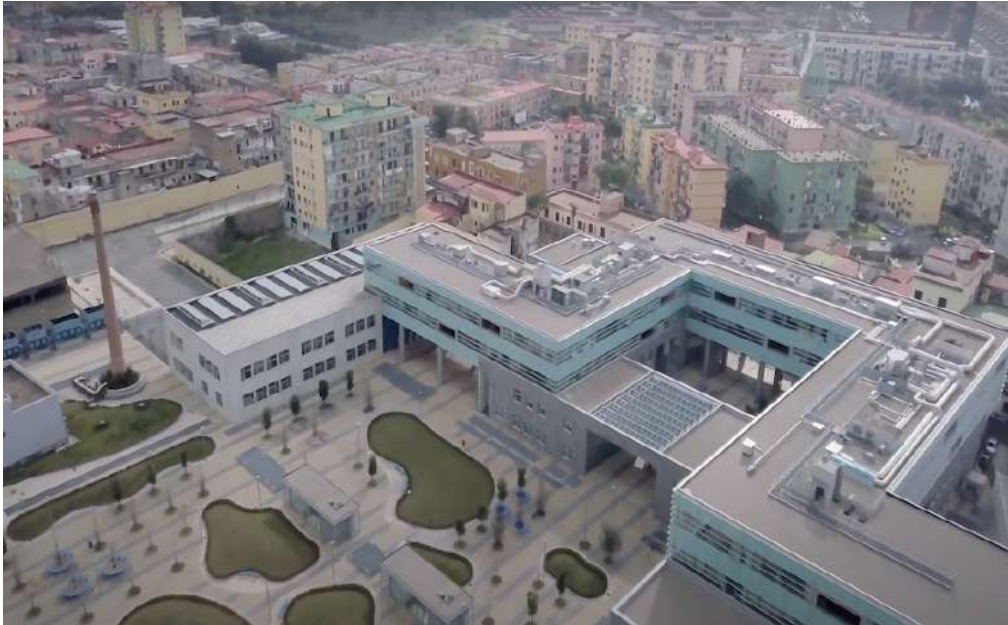
Fig. 4| Ripresa dell'alto del campus di San Giovanni. Fonte: Archivio POR Campania FESR.
