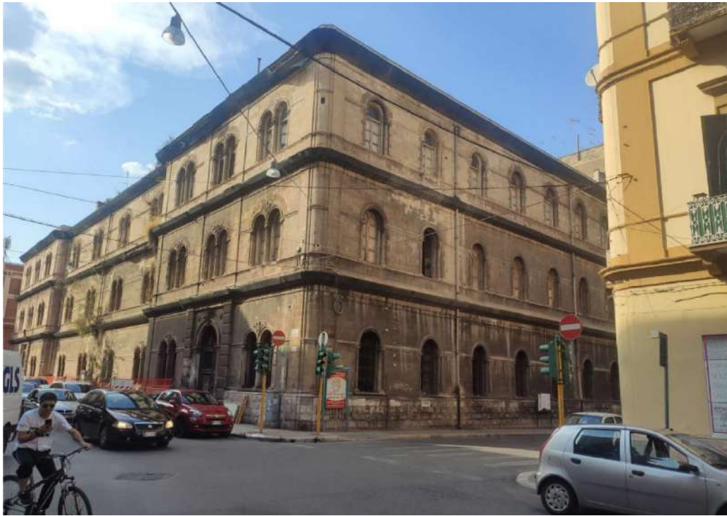
Fig. 1| Esterno di Palazzo Frisini, stato attuale.
